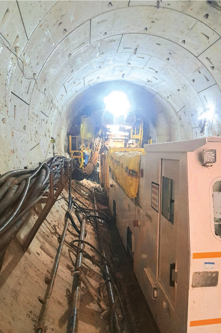
भोपाल रेलवे स्टेशन से पुल पातरा तक जमीन के नीचे टीबीएम से टनल बनाने का काम चल रहा है।
